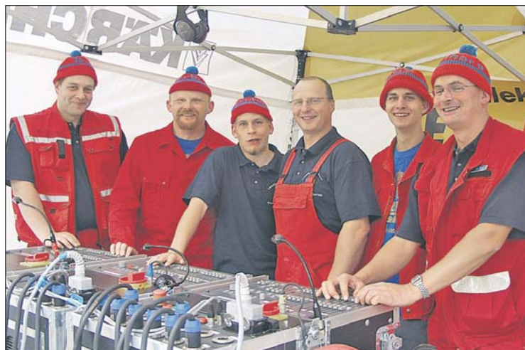
Das Elektrikteam der Wasserspiele weihte bei der Sommernacht im Halifax die neue digitale Lichtsteueranlage ein. Fotos: wu
